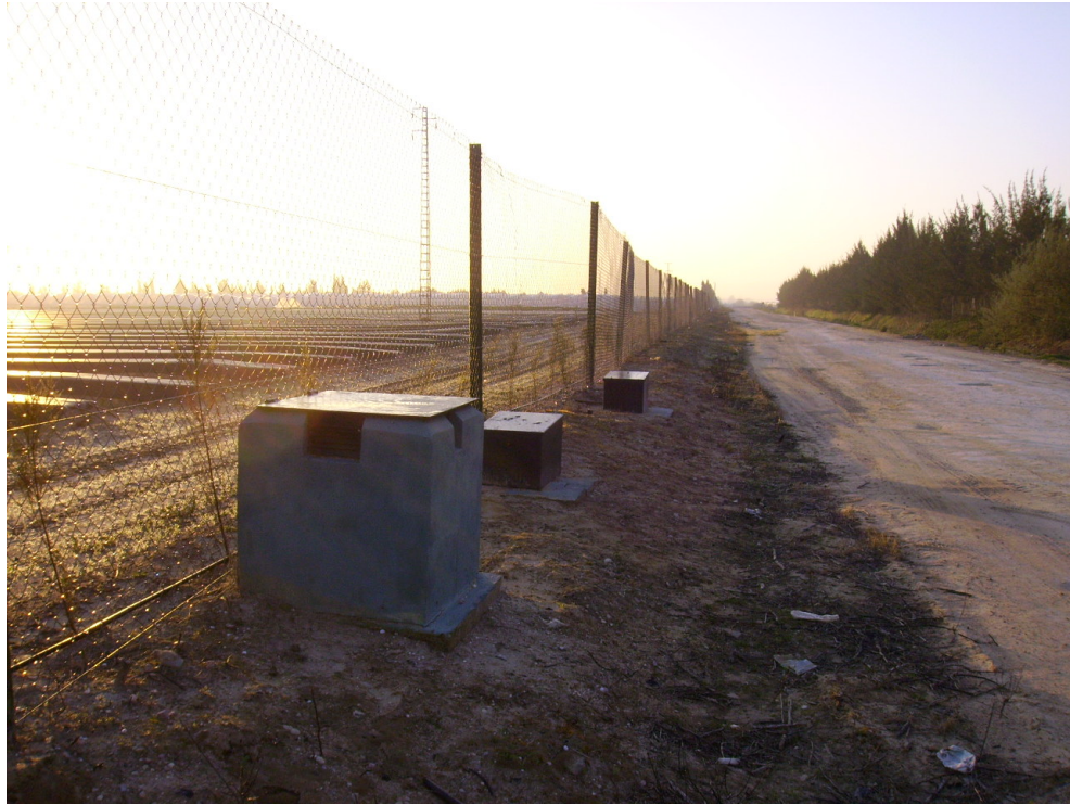
Piezómetros a distintas profundidades controlados por la Agencia Andaluza del Agua
