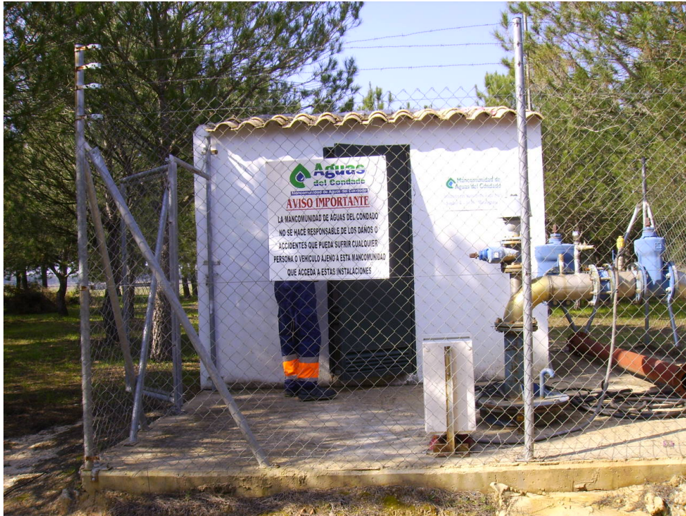
Sondeo de abastecimiento Matalagrana 2 (Recinto vallado).
