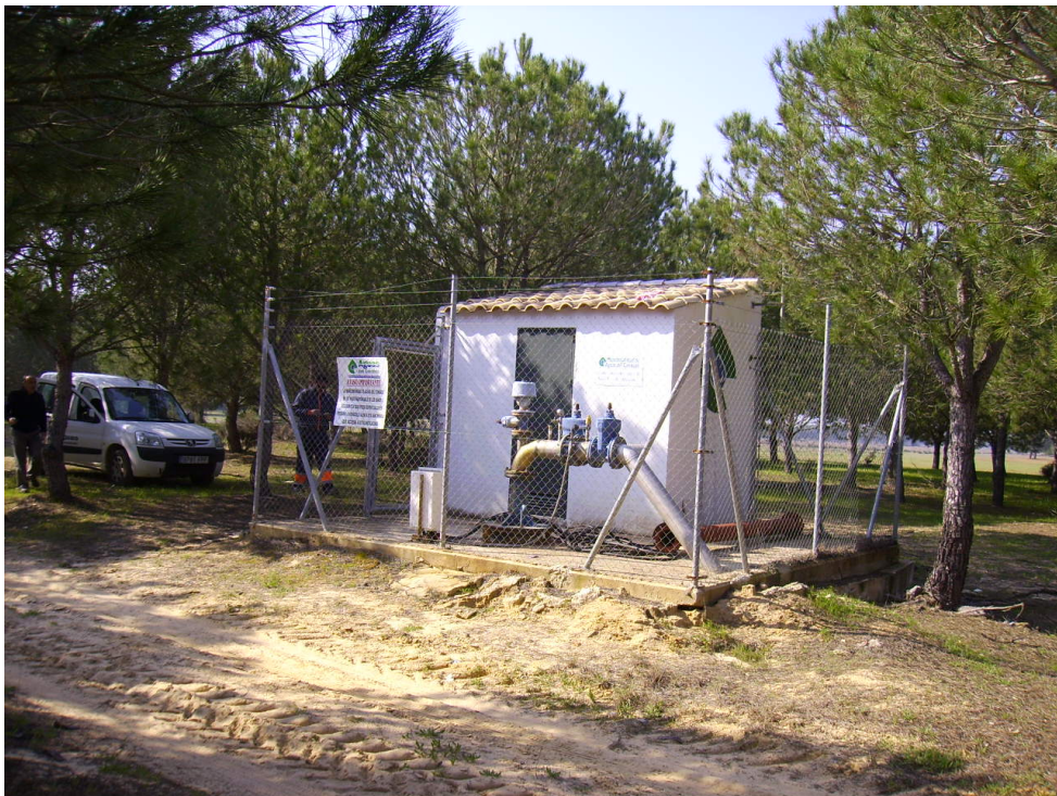
Sondeo de abastecimiento Matalagrana 2 (vista general).
