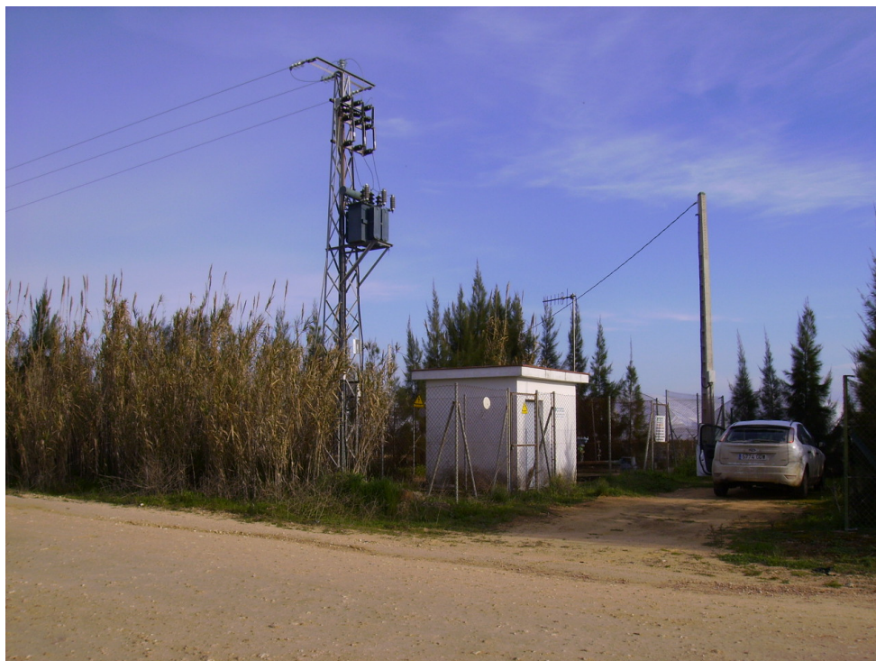
Sondeo de abastecimiento la Higuera (vista general).
