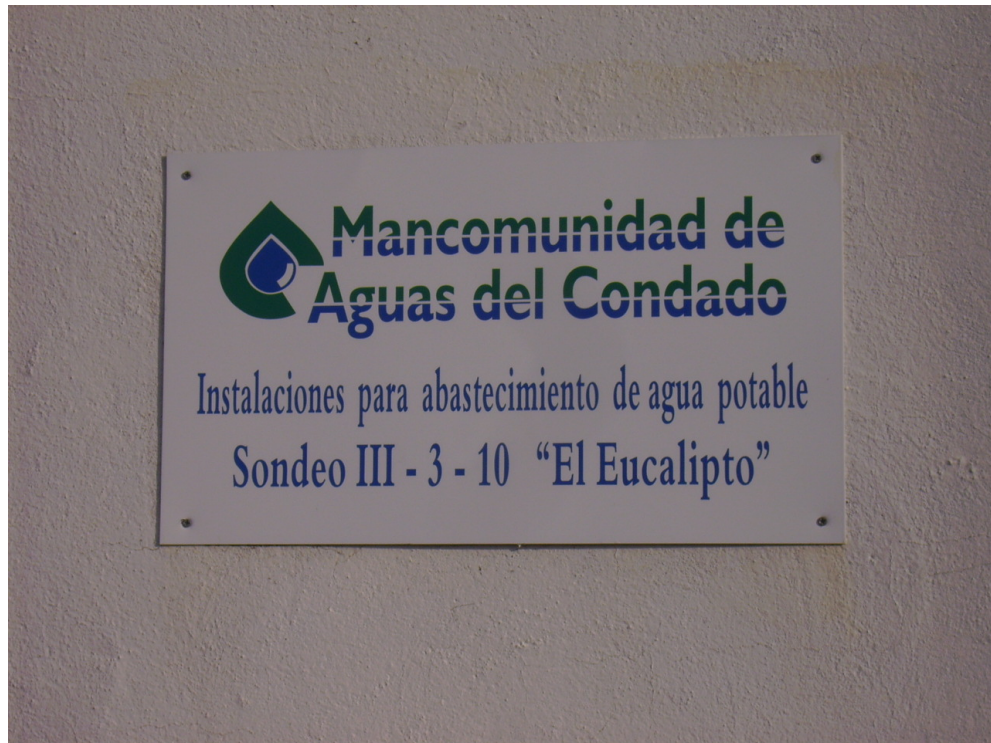
Rótulo en caseta de cuadro eléctrico del sondeo de abastecimiento el Eucalipto.
