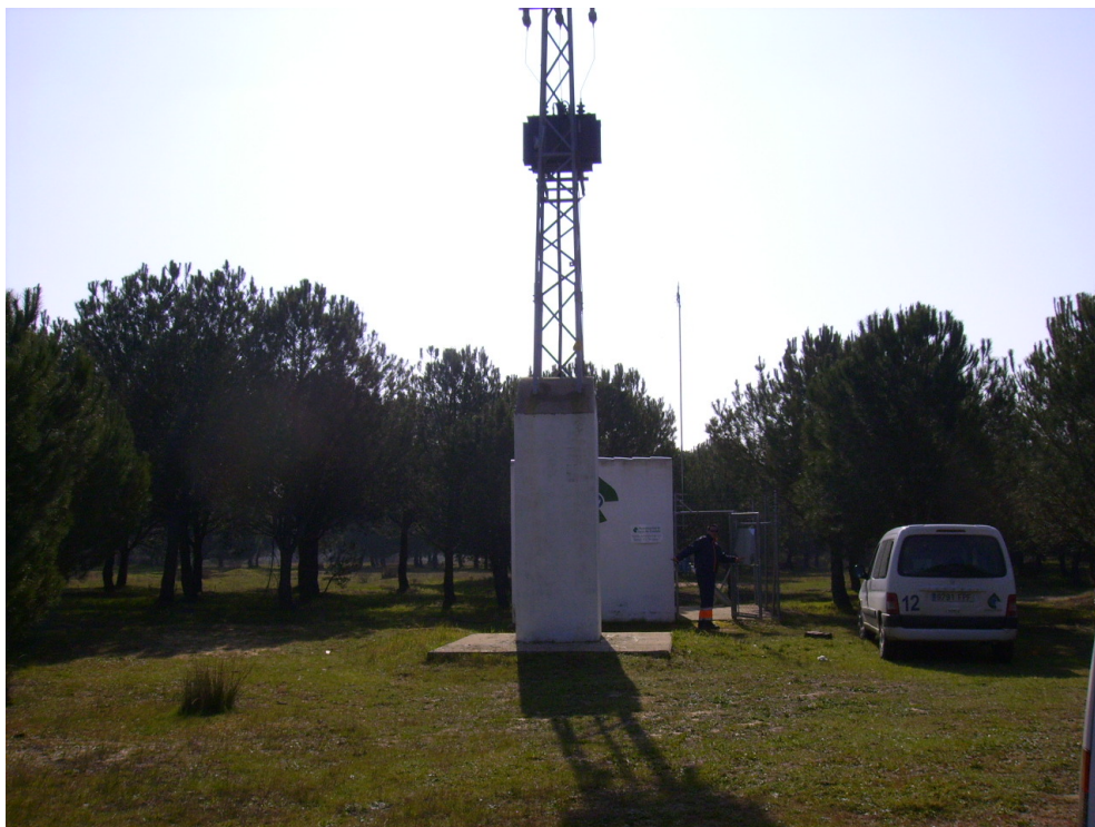
Sondeo de abastecimiento Matalagrana 1 (vista general).
