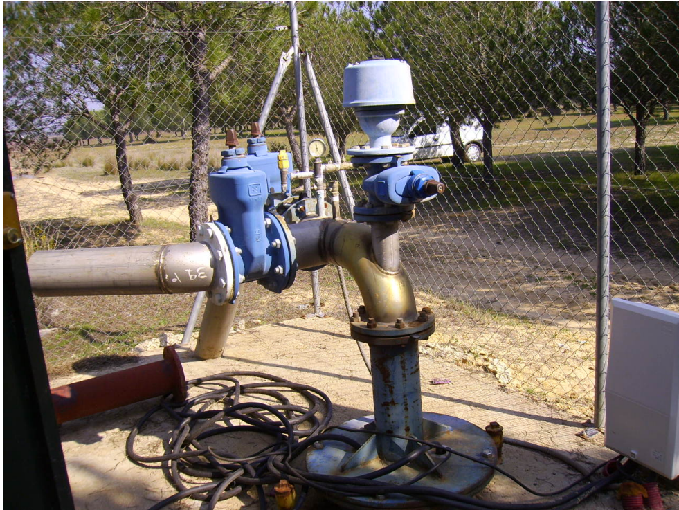
Sondeo de abastecimiento Matalagrana 2 (Sondeo V-3-16).
