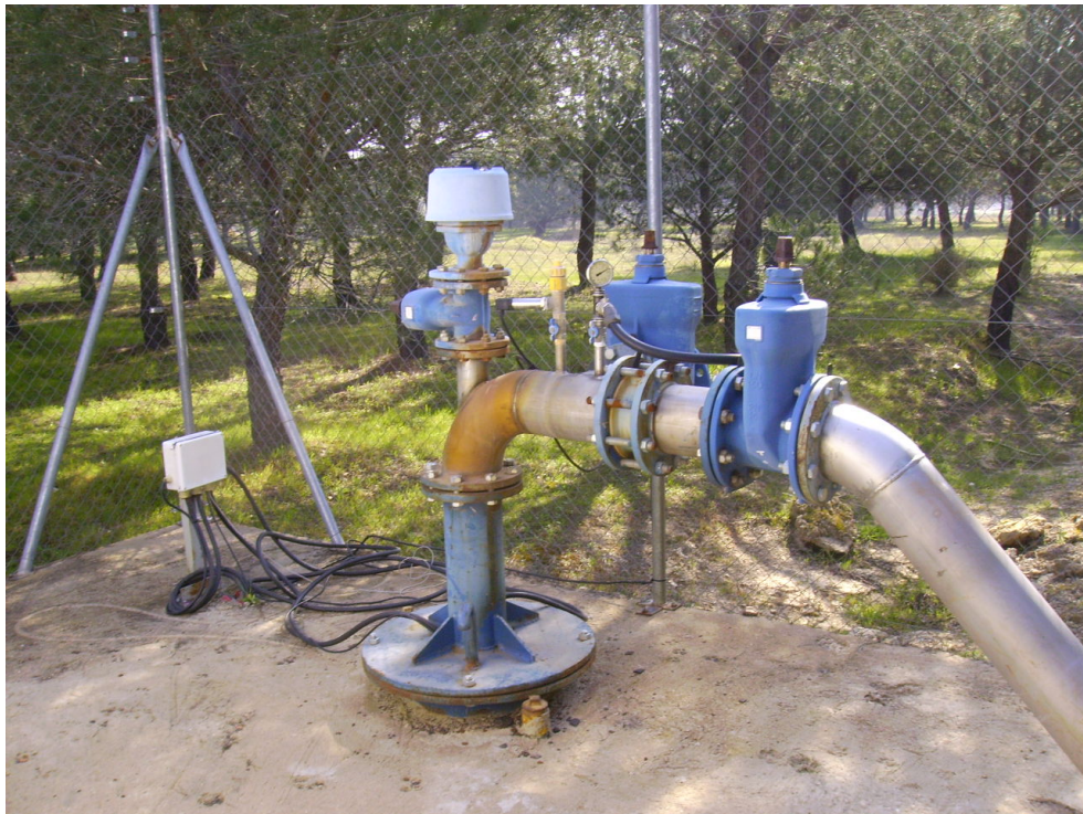
Sondeo de abastecimiento Matalagrana 1 (Sondeo V-3-06).
