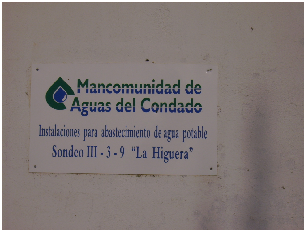
Rótulo en caseta de cuadro eléctrico del sondeo La Higuera.
